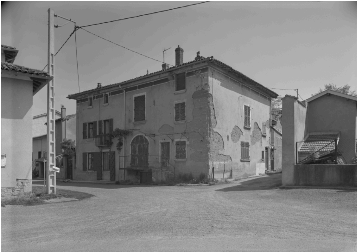
Vue d'ensemble du presbytère depuis le sud-est
