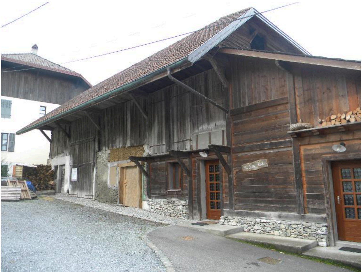
Vue d'une ancienne étable modifiée en gîte (2008 E10 1533).
