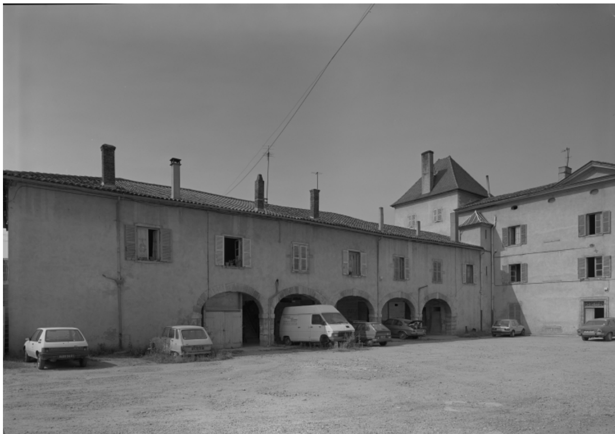
Aile gauche, élévation sur cour.
