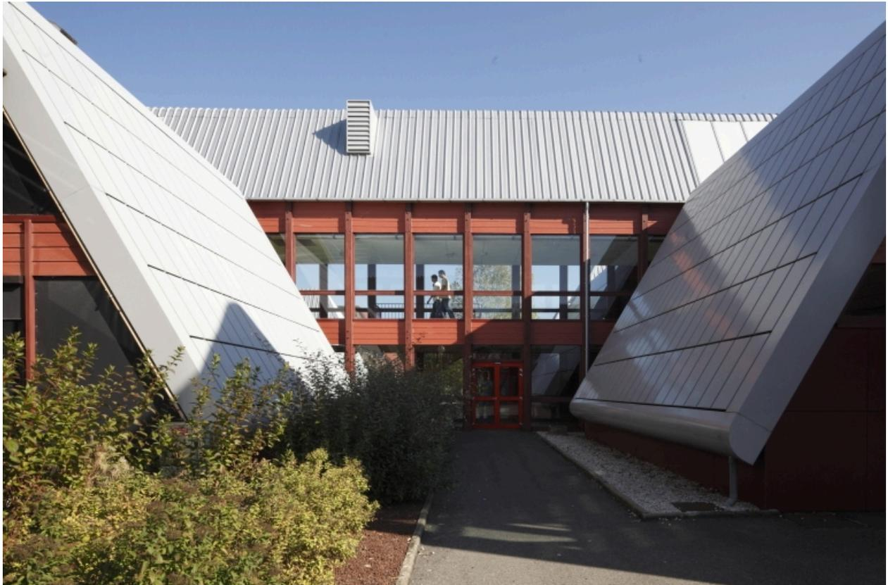
Depuis la cour intérieure, galerie de liaison entre le bâtiment A (à gauche) et le bâtiment E (à droite). Remarquer l'occultation des panneaux solaires remplacés par des bacs tôle et de l'éclairage zénithal sur les poutres tridimensionnelles.
