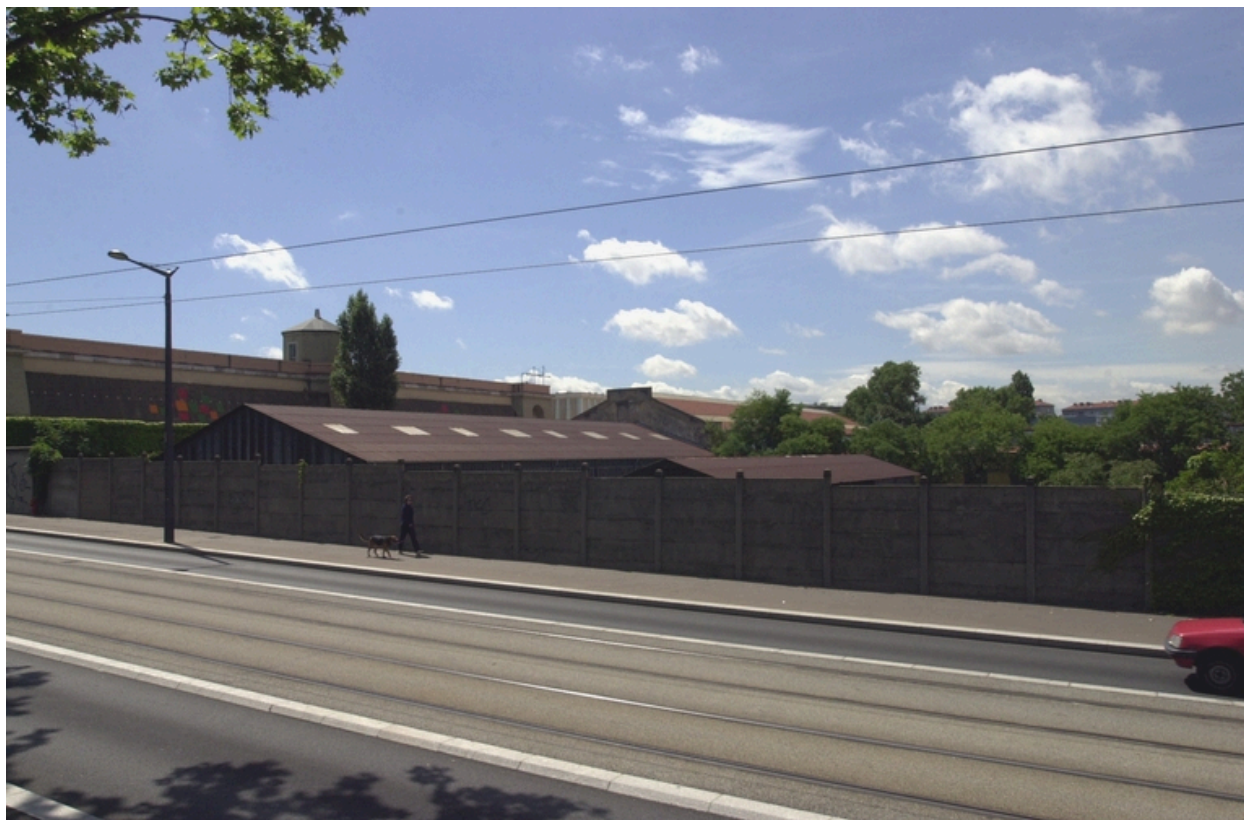
Vue d'ensemble nord-est
