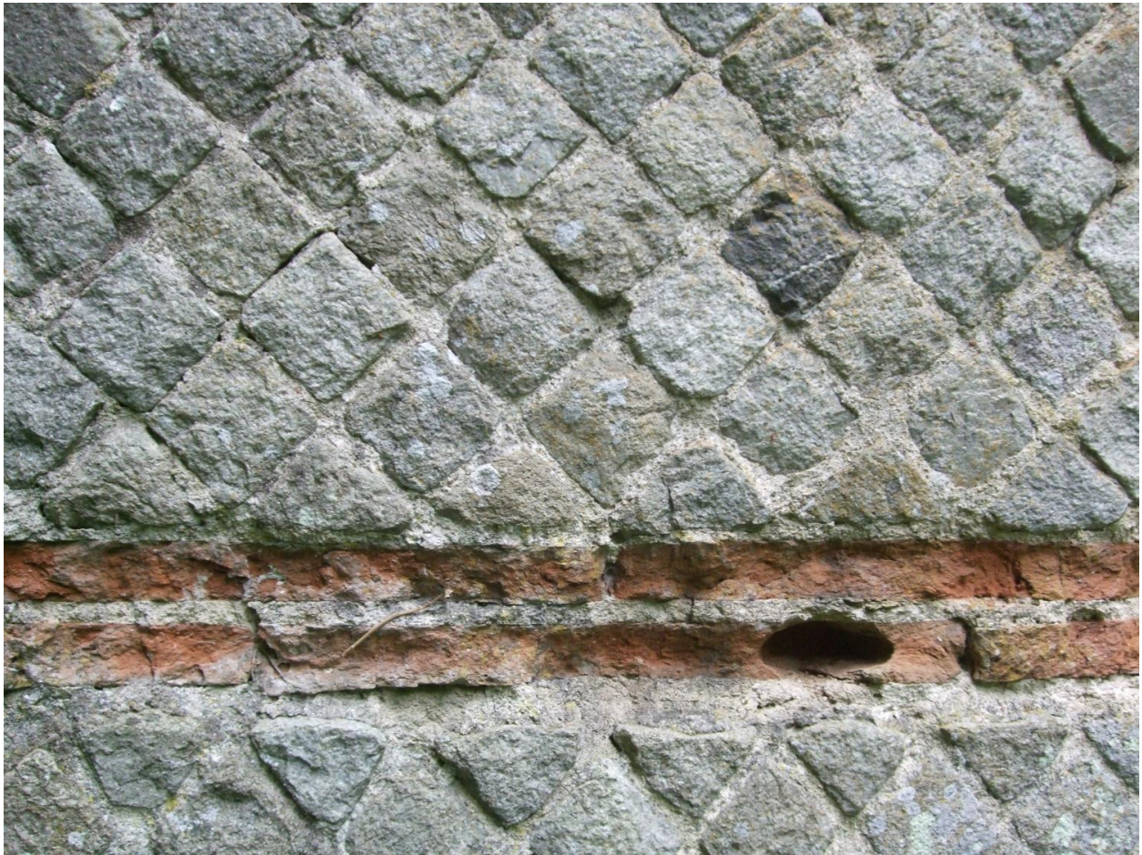
Appareil réticulé de l'aqueduc romain du Gier
