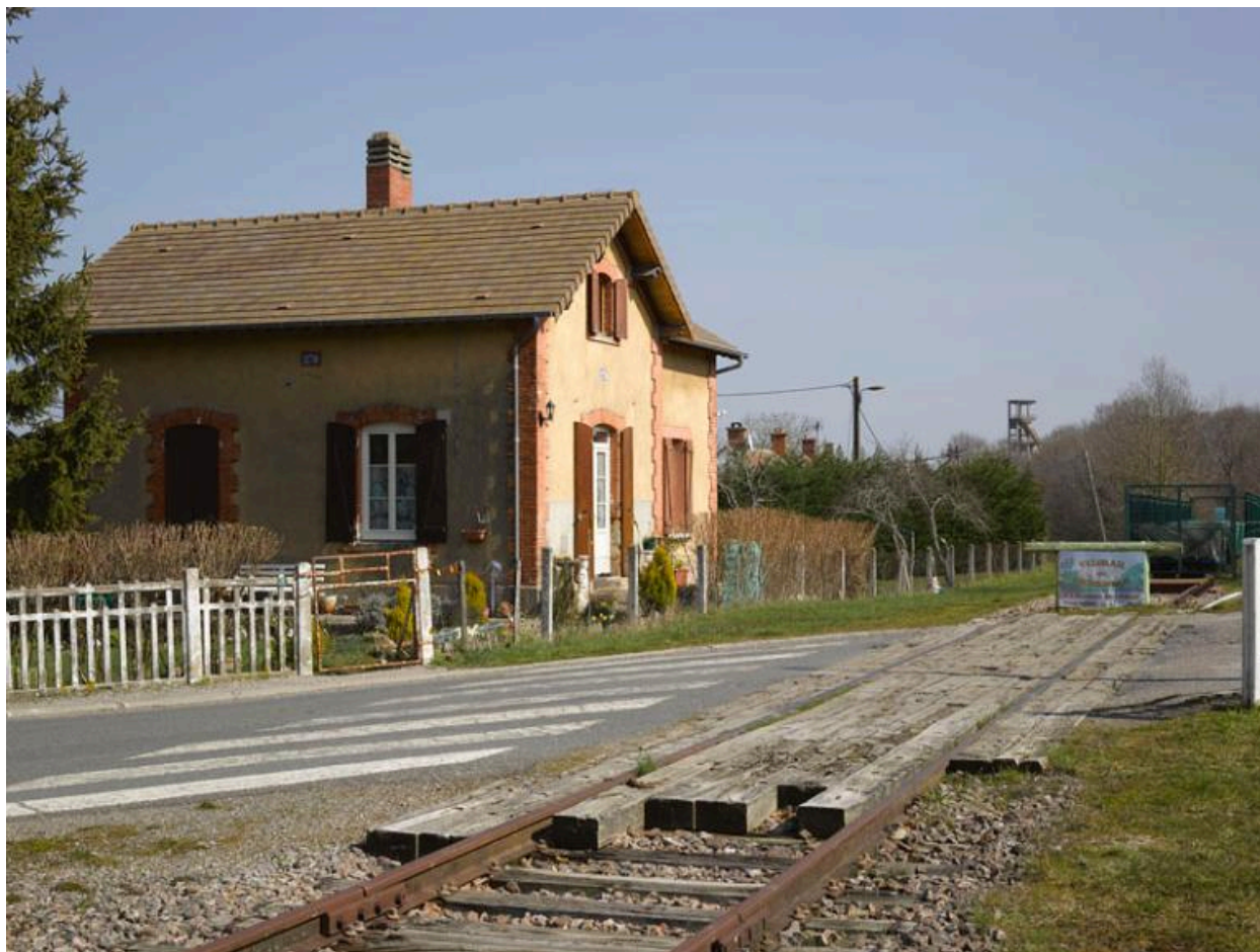
Vue générale d'un passage à niveau et de la maison de garde-barrière à Noyant-d'Allier.
