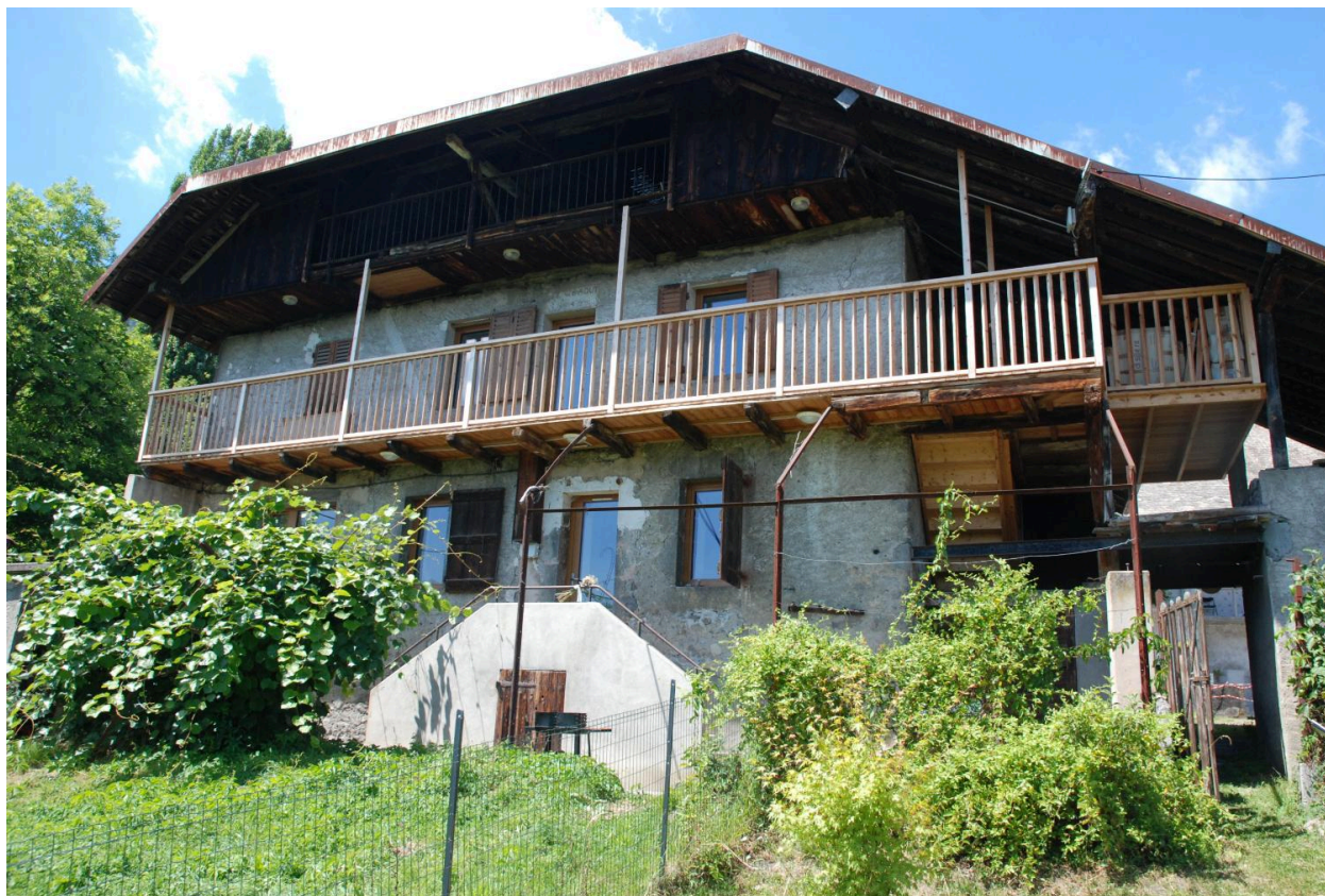
Maison de vigneron (2018 I1 191), vue sud.
