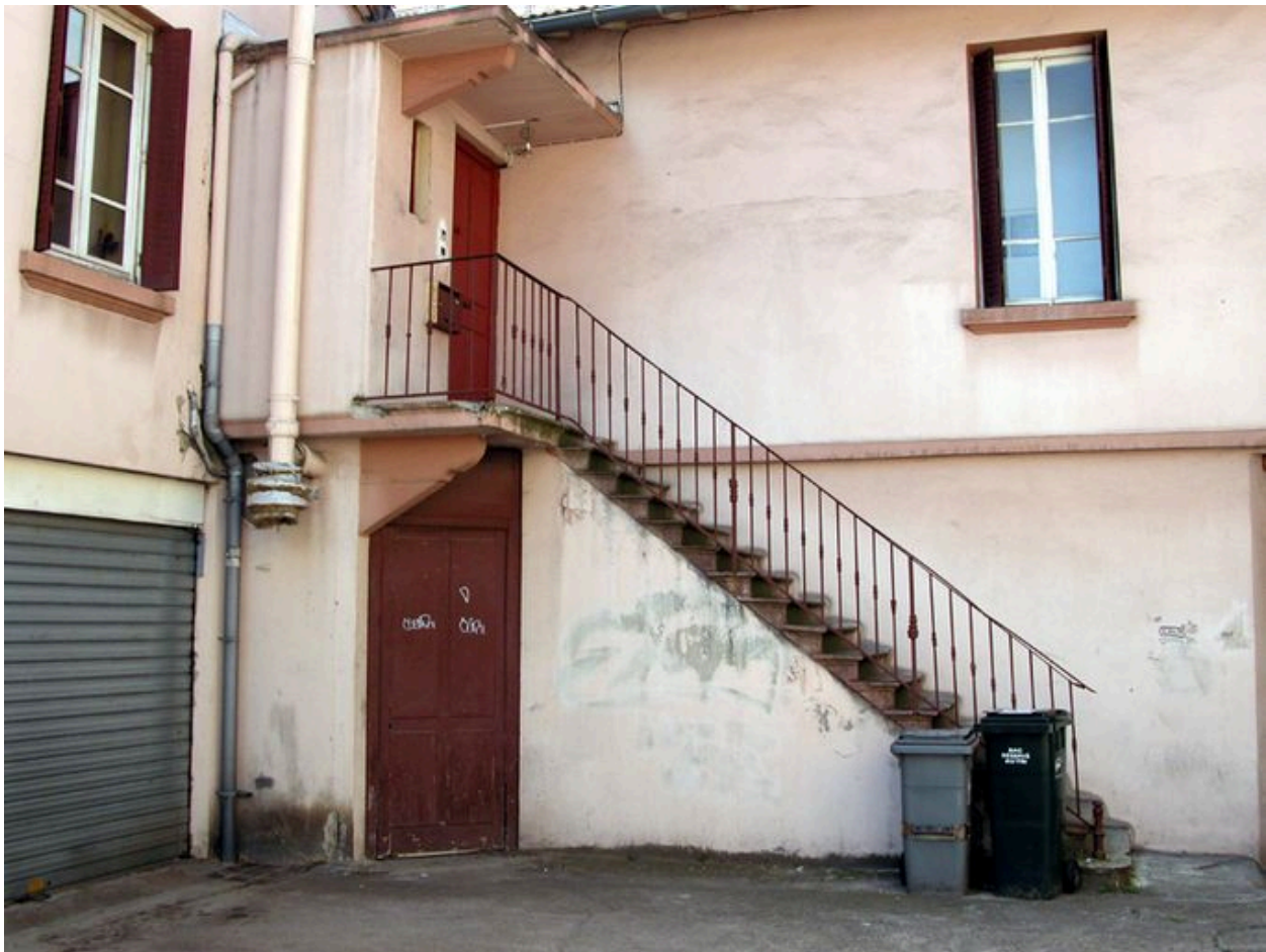
Bâtiment de garages et logements, façade sur la deuxième cour
