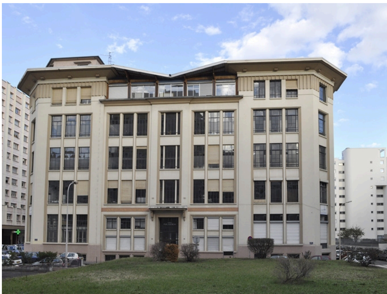
Vue générale, façade principale
