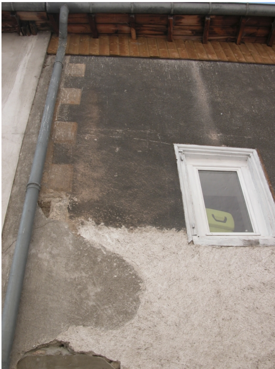
Îlot 2. Roanne (rue de) 13, 15. Détail du chaînage d'angle peint de la façade sur la traversière Saint-Jean.
