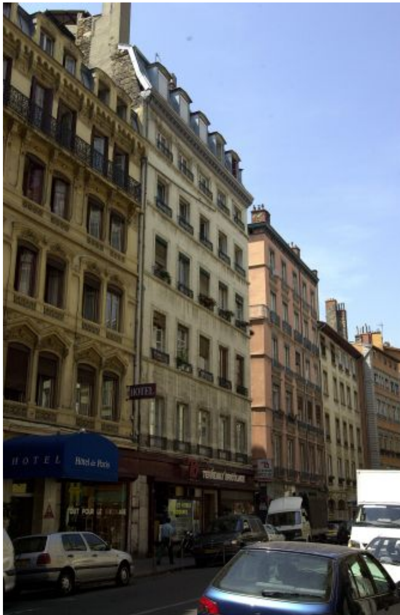
Façade principale, rue de la Platière
