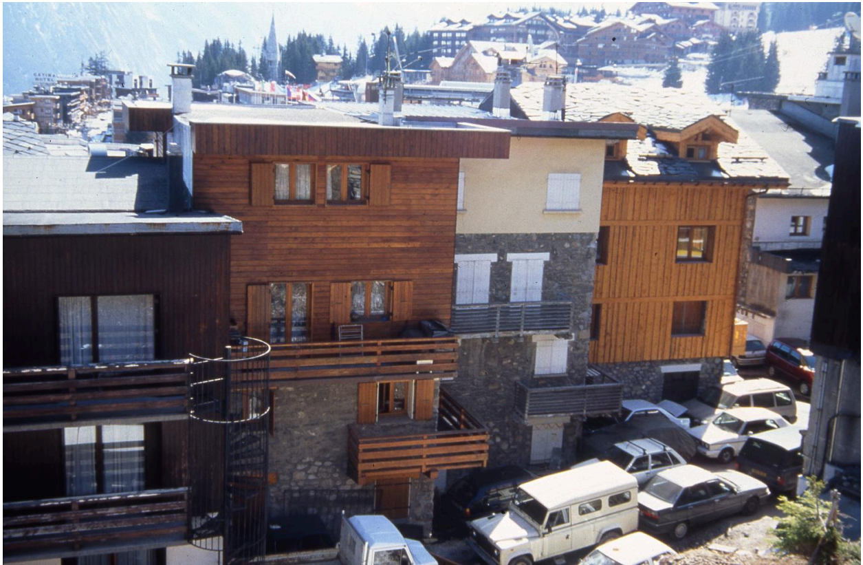
Elévation postérieure après travaux
