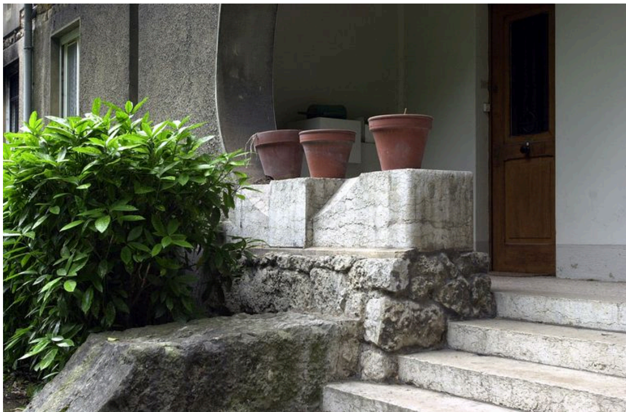
Façade principale, détail du porche centrale
