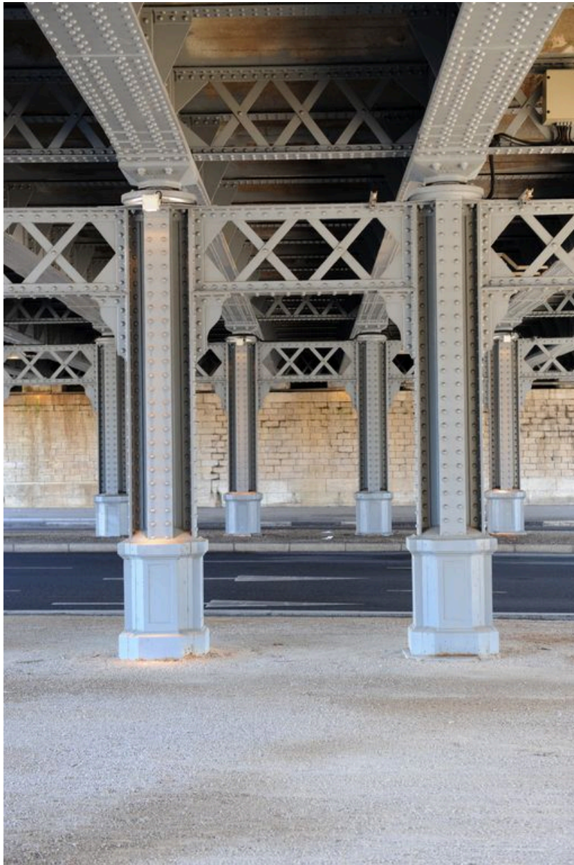
Travée de rive gauche, vue partielle : de dessous, jonction des piles avec le tablier
