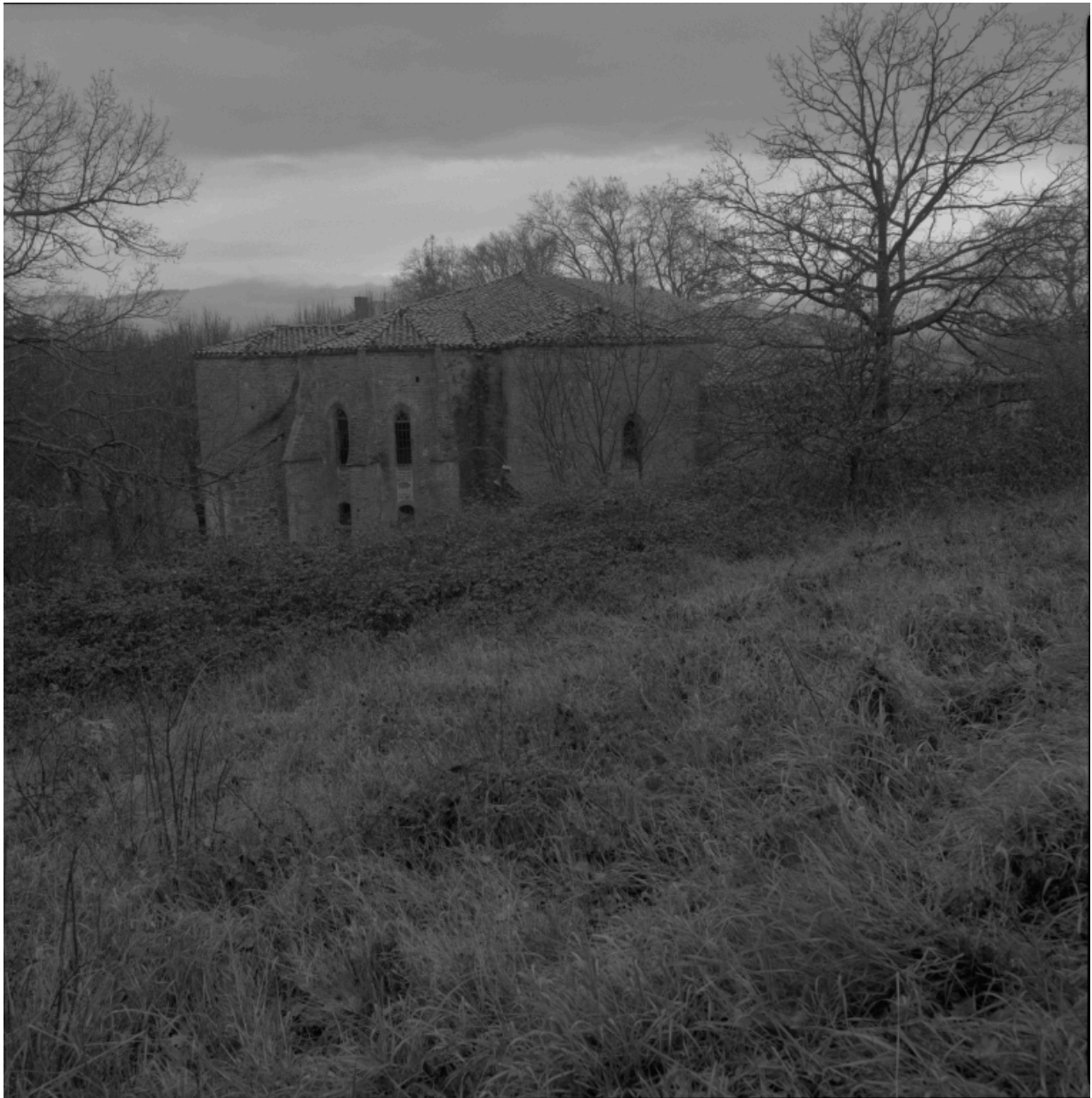
Vue générale du chevet.
