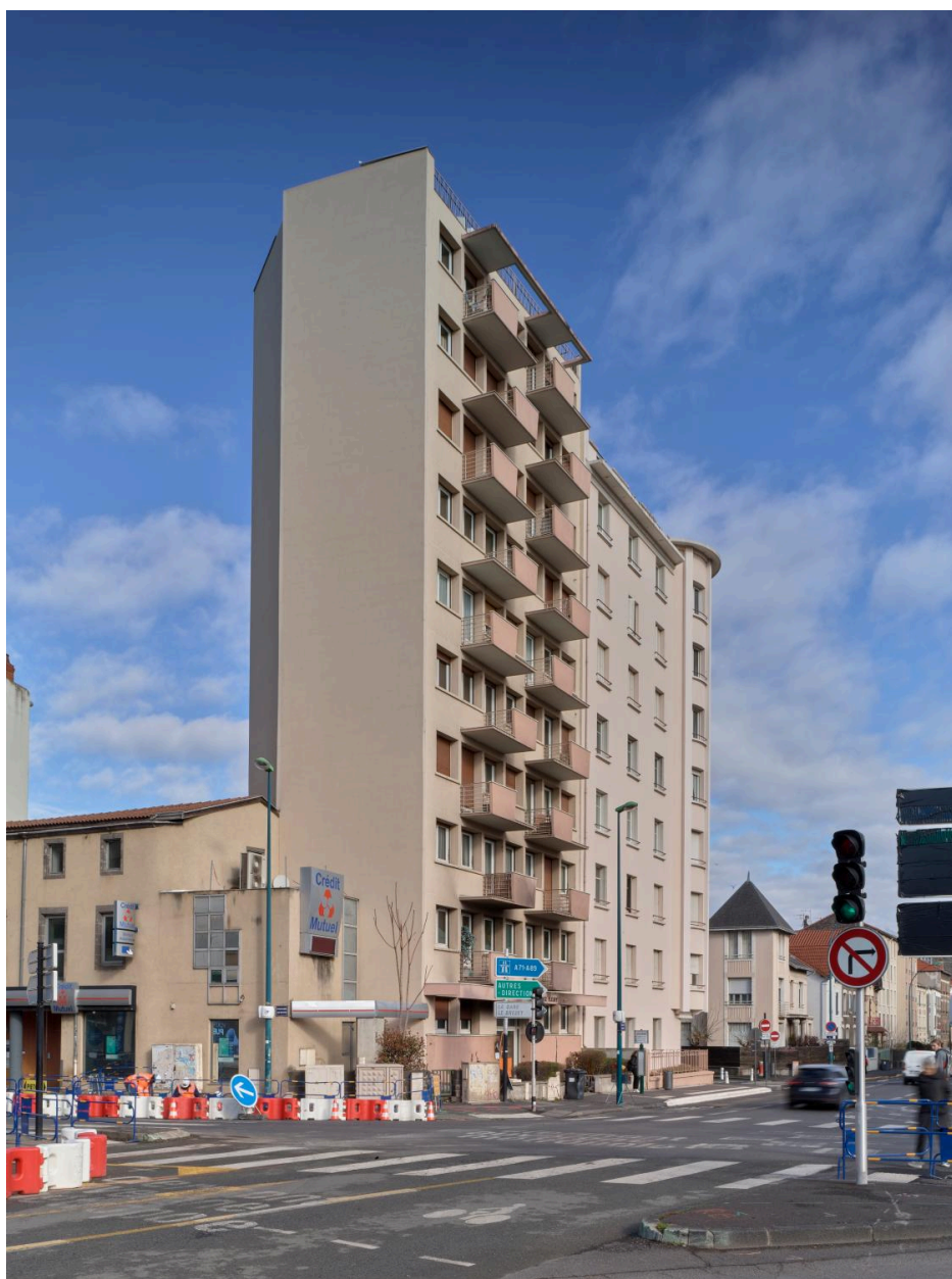
Pignon du 24 boulevard Fleury
