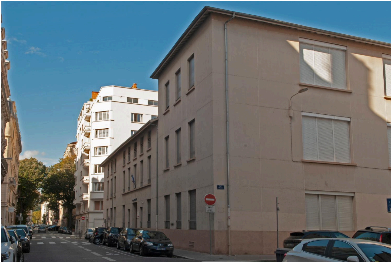
Elévation principale, depuis le sud
