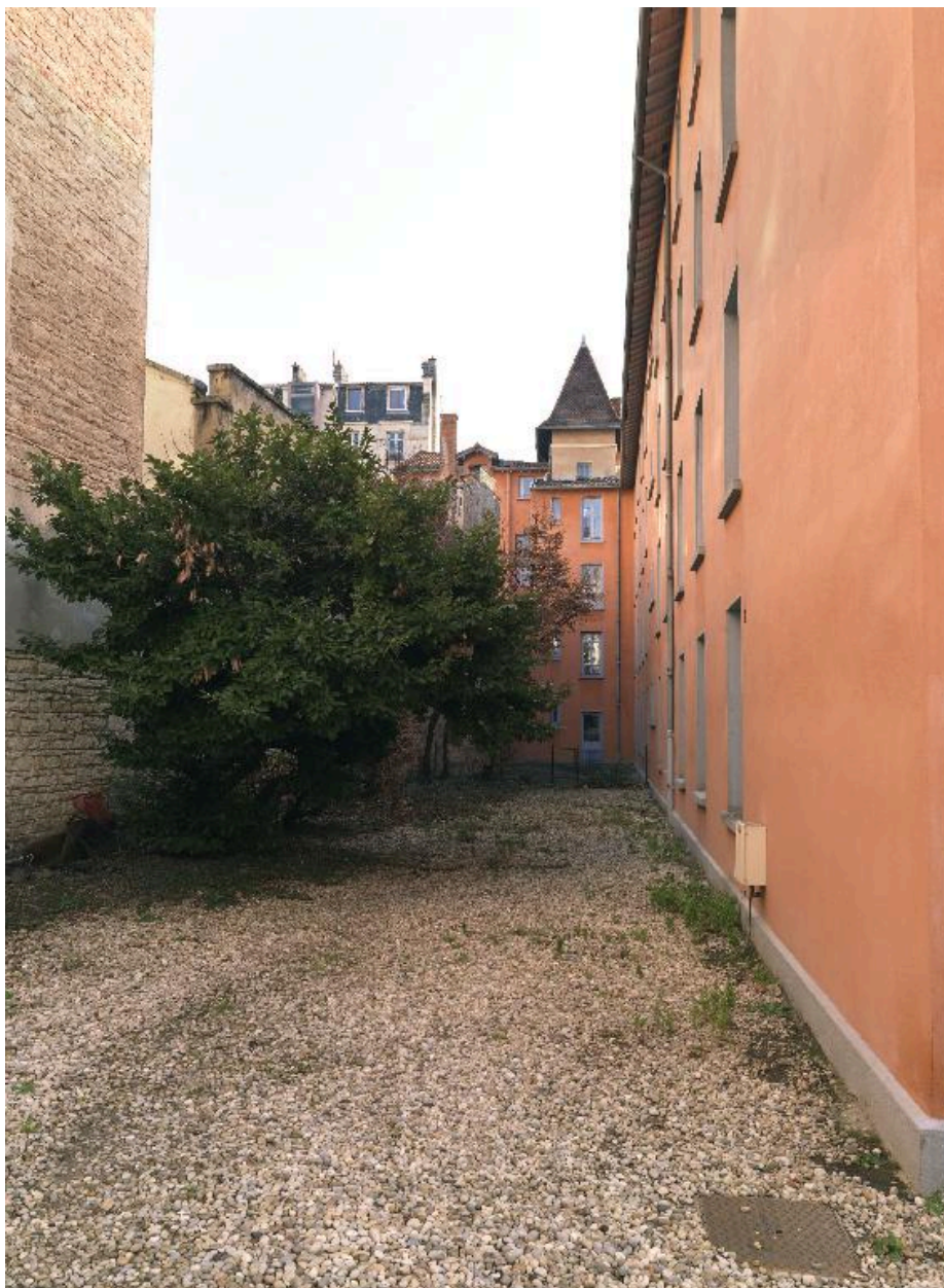
Vue de l'élévation ouest des dortoirs.
