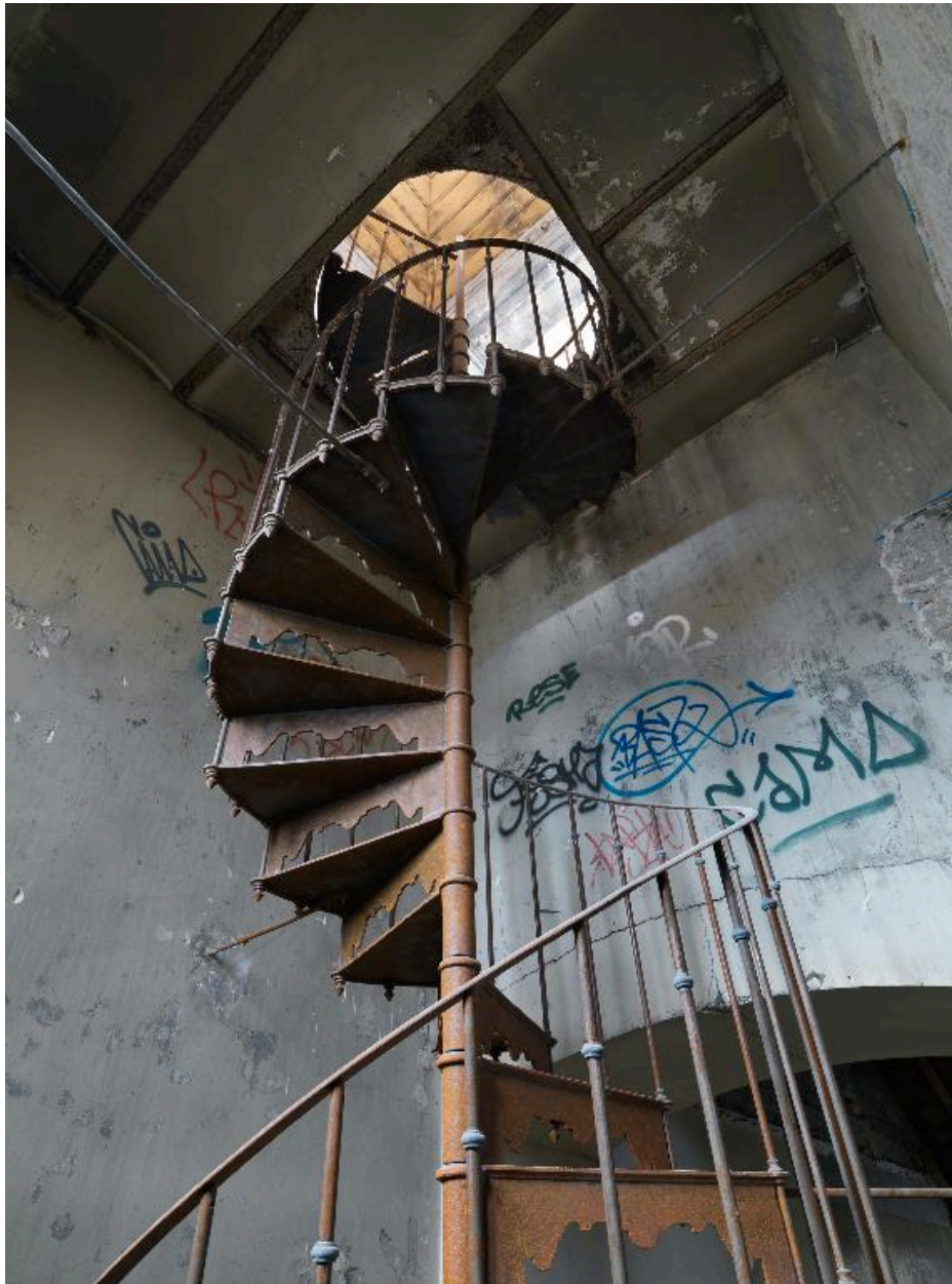
Etat en janvier 2015 : bâtiment B, partie centrale, l'un des deux escaliers du belvédère
