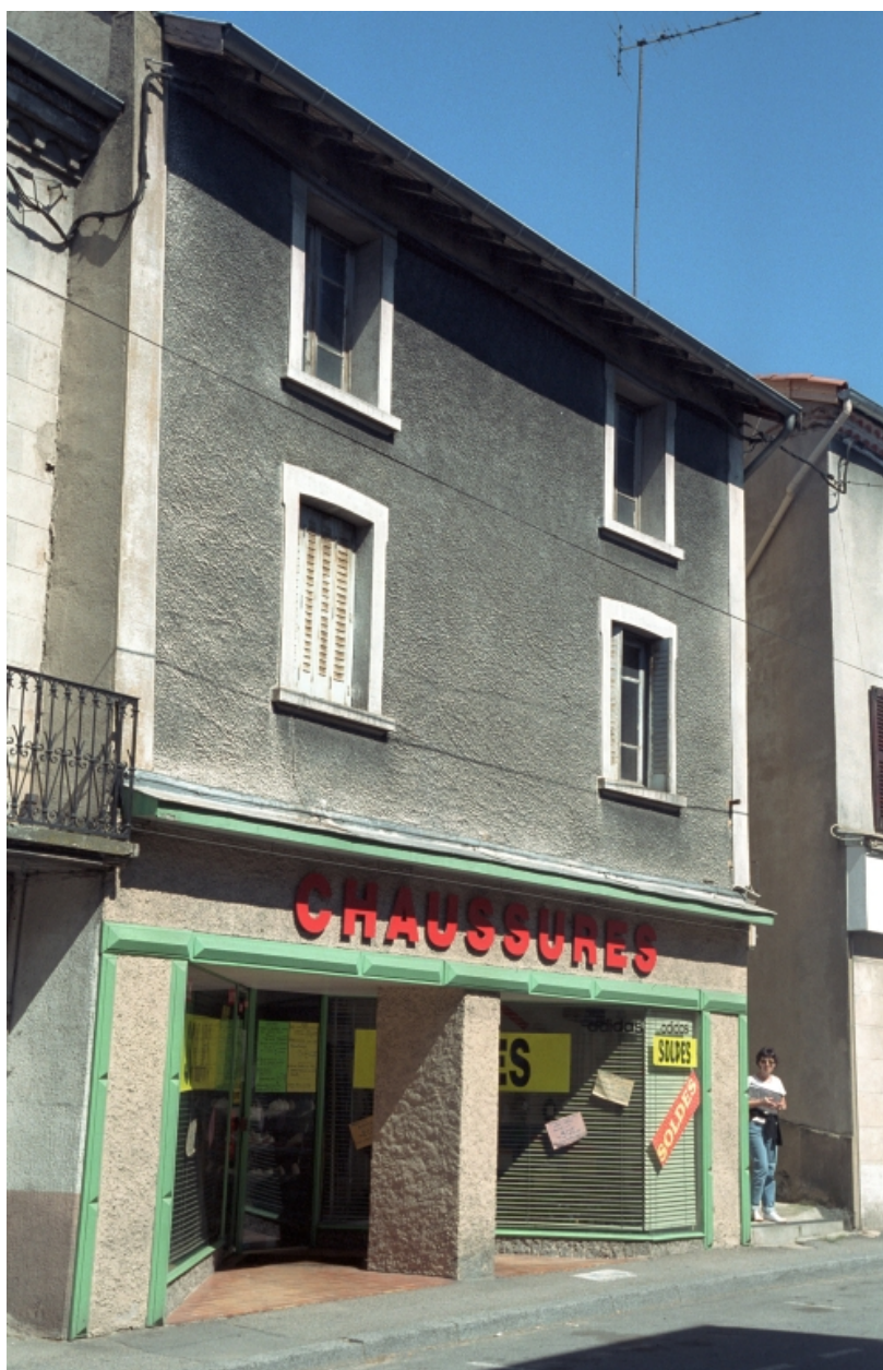
Boën, îlot 12, Clermont (rue de) 35. Vue générale de la façade sur rue.
