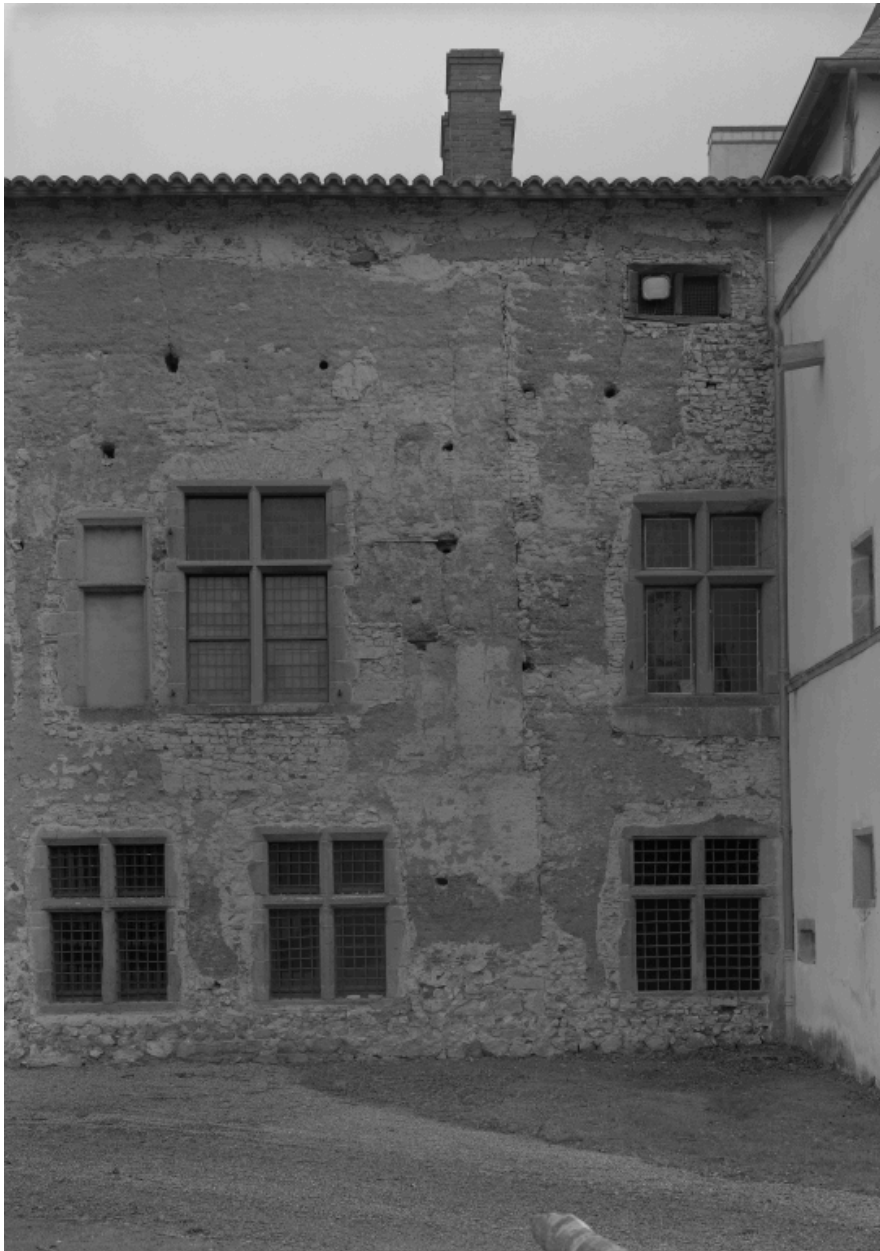
Façade sur jardin du corps de galerie après décroûtage : détail de la partie sud accotée au corps primitif en pisé.
