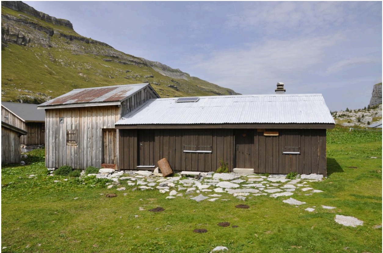
Vue d'ensemble des deux chalets contigus
