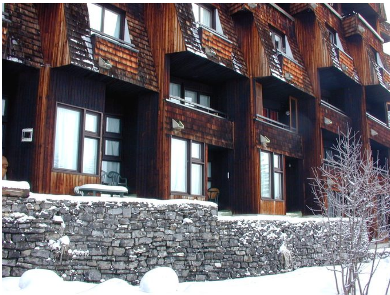
Détail de la partie basse de l'élévation sud
