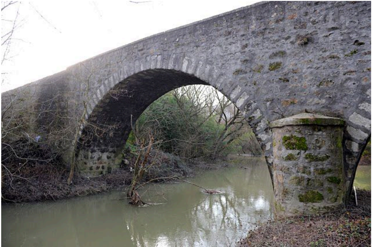
Vue de l'arche de rive gauche, face amont
