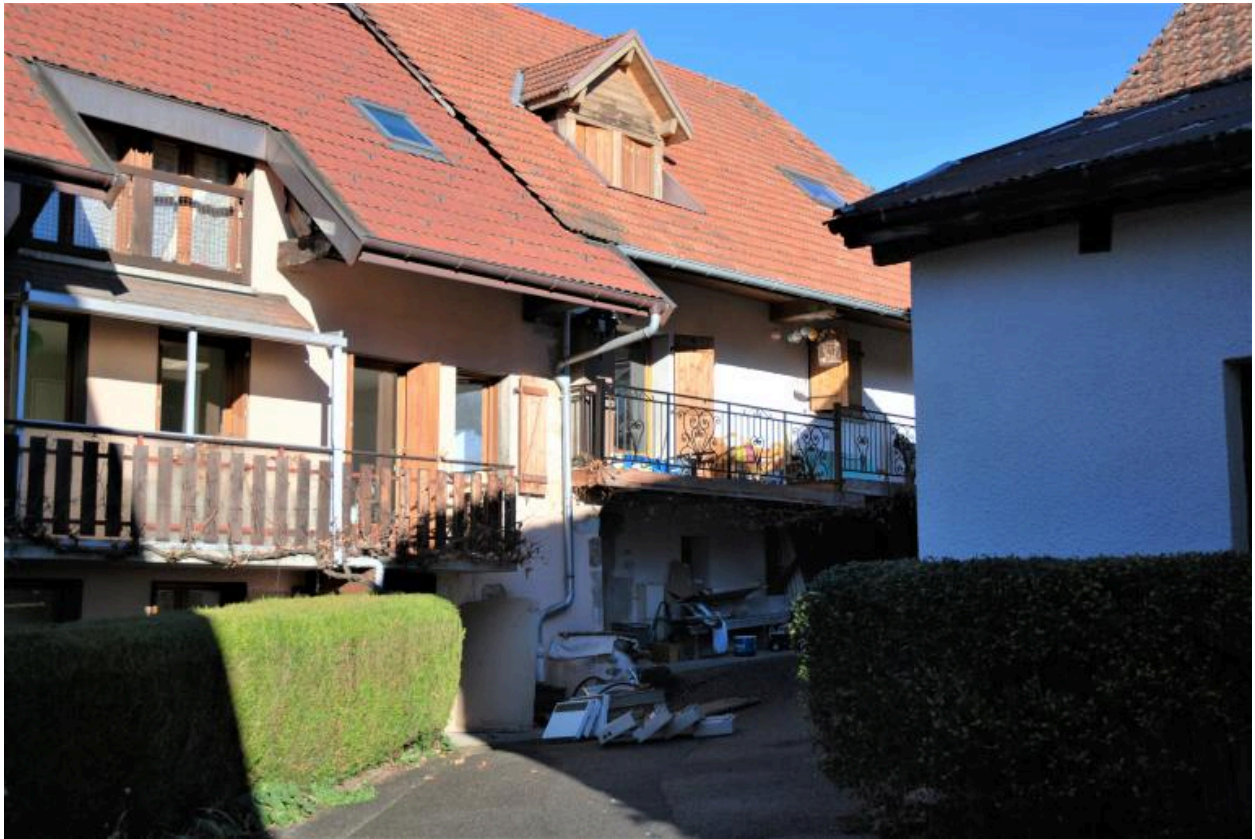
Vue partielle de Viuz-Nord. Fermes accolées C4 1980.
