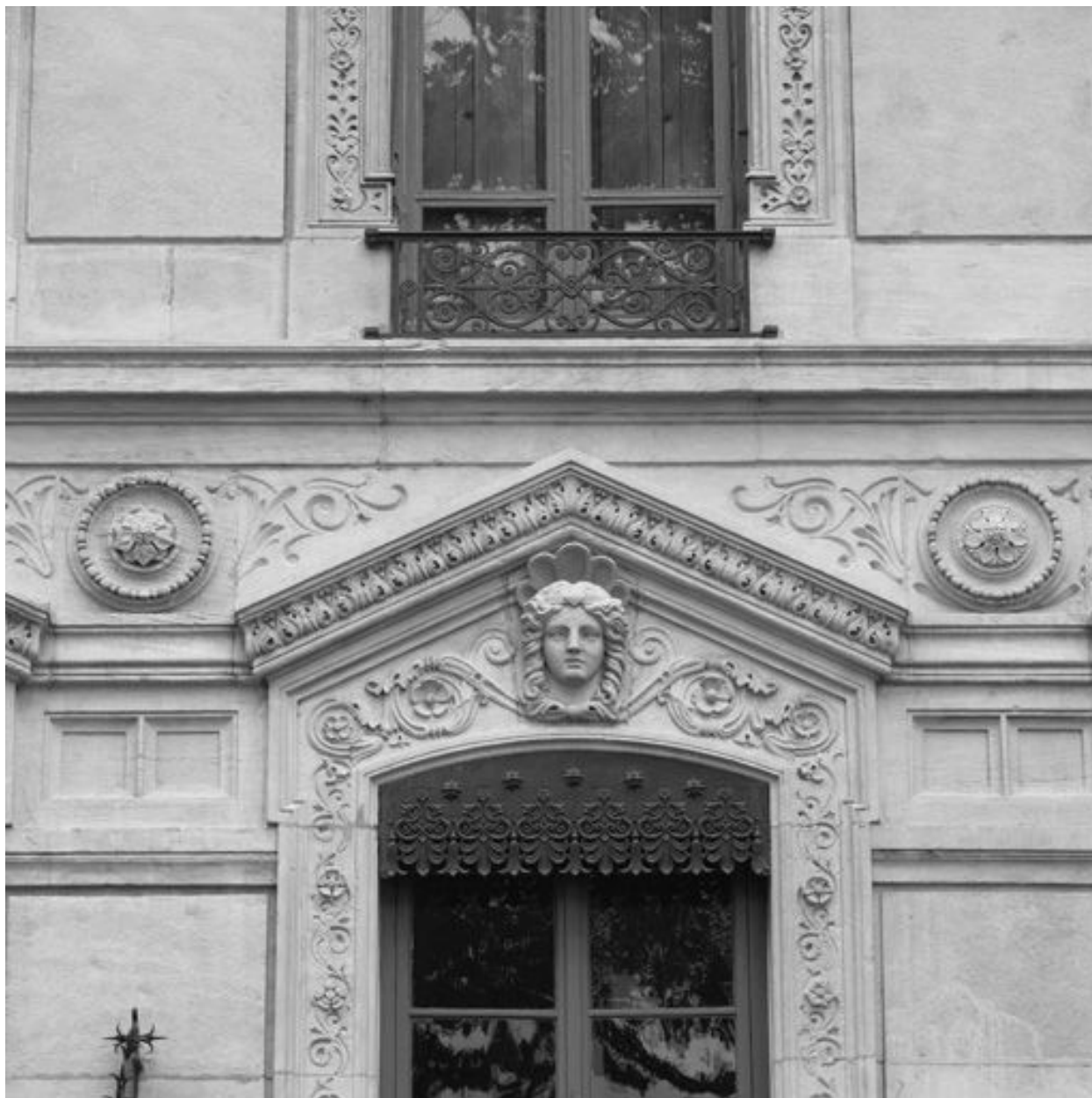
Façade, détail de la 4e fenêtre du 2e niveau
