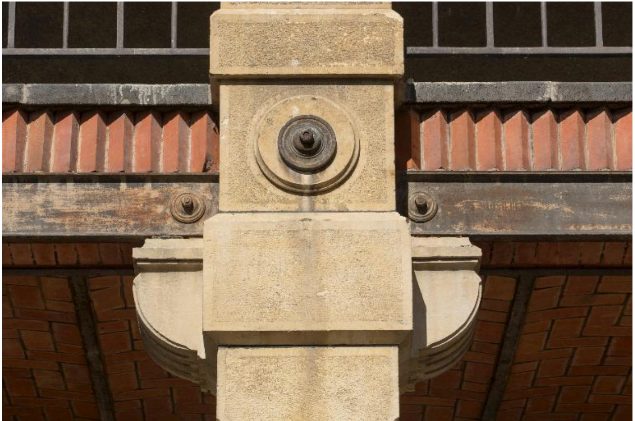
Bâtiment A. Détail de l'ornementation de façade des galeries
