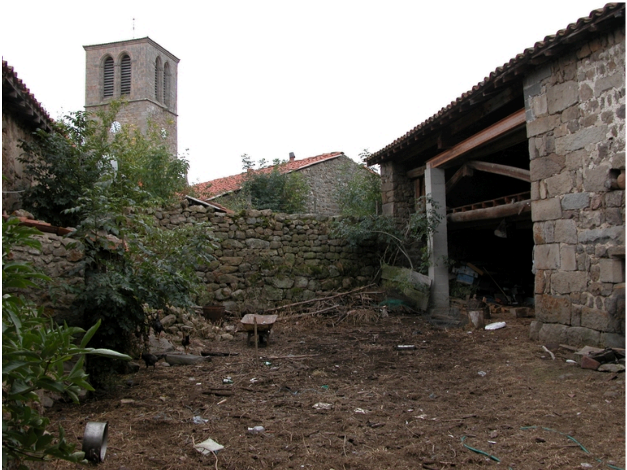
Vue de la cour, depuis le nord ; à droite, le passage couvert-cuvage.
