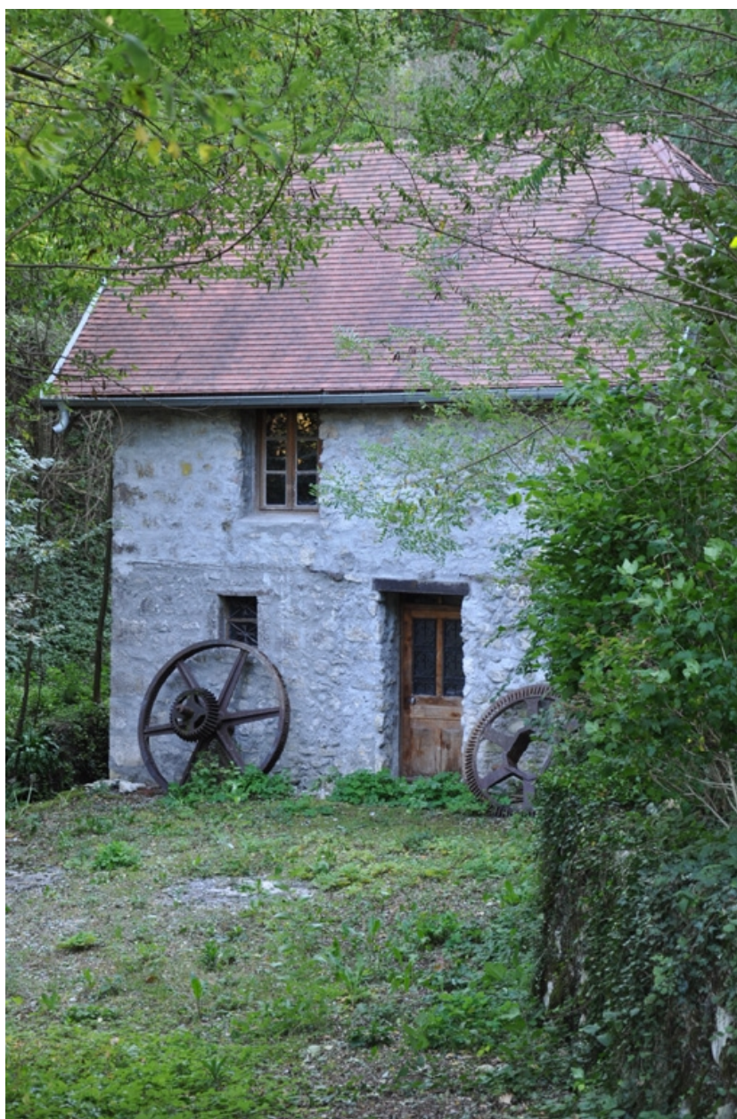
Vue générale du moulin, façade nord
