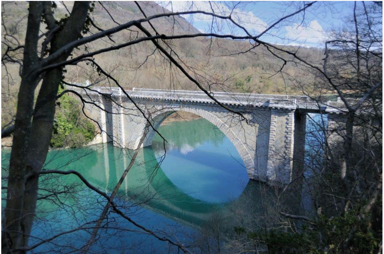
Vue du pont Carnot (Collonges, Ain), face amont ; pont à voûtes (1873)
