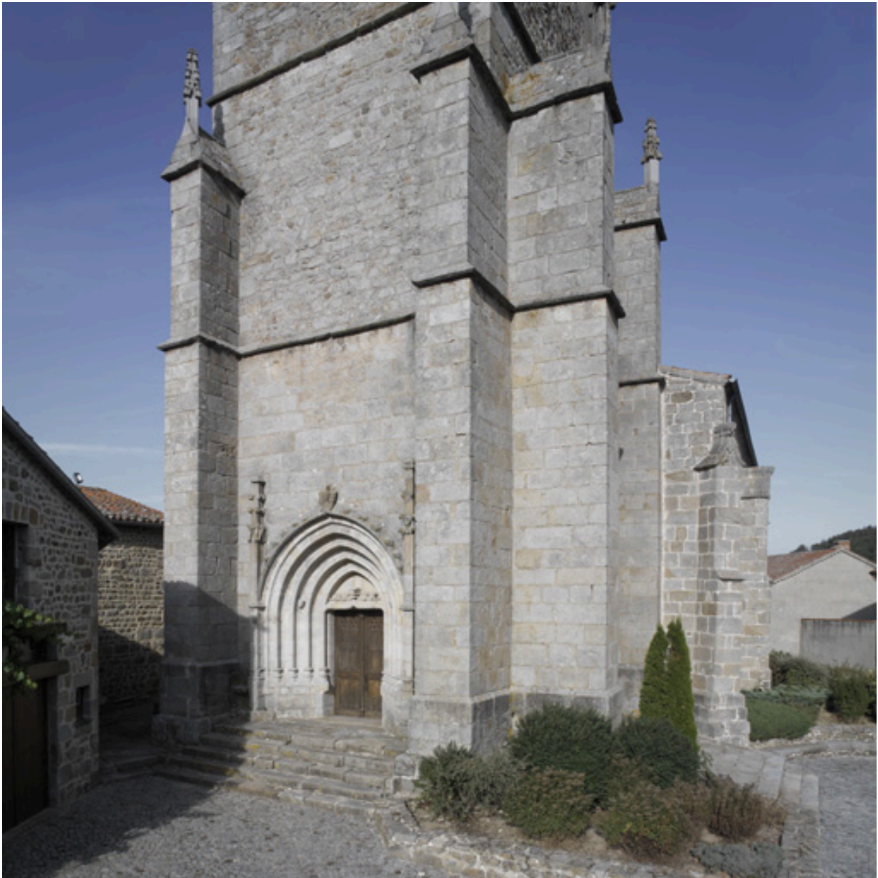
Vue partielle de la face principale du clocher
