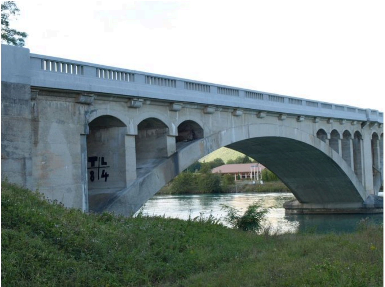
Vue d'une arche (travée de rive gauche)
