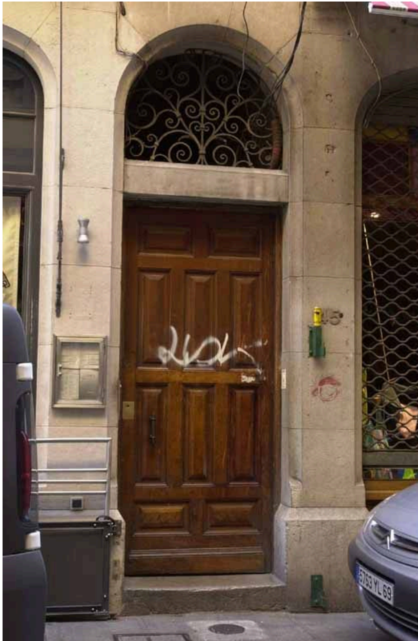
Rue Mercière, élévation antérieure : la porte
