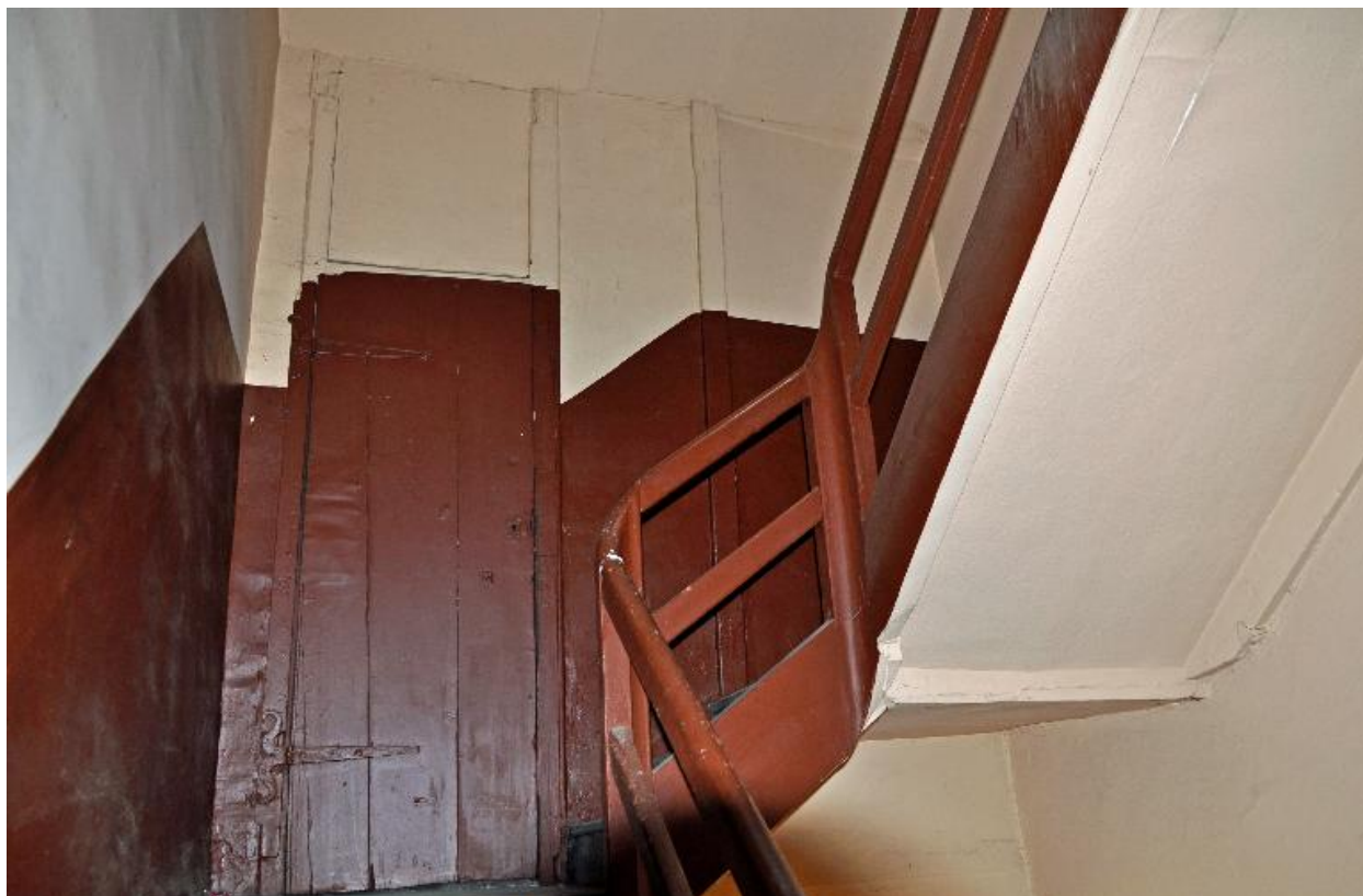
Dernier étage : escalier en charpente et paroi en pan-de-bois
