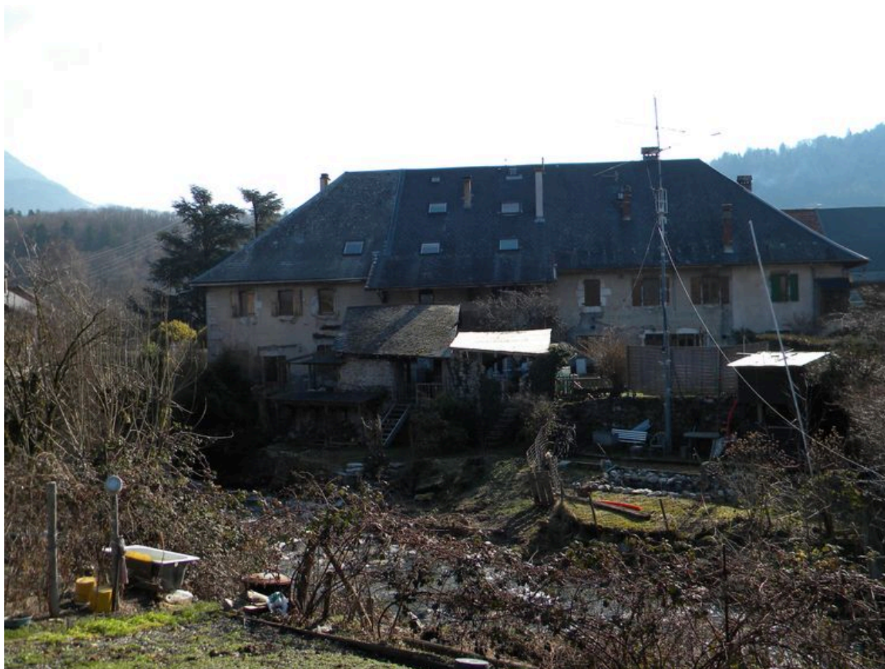
Vue de la façade arrière.
