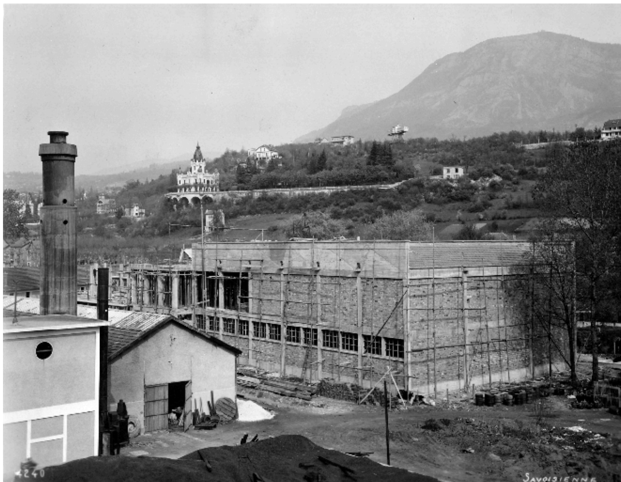
Bâtiment V en construction
