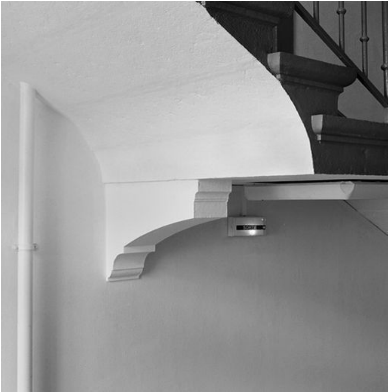
Aile sud du cloître, grand escalier, détail du repos interrompant la montée vers le deuxième étage
