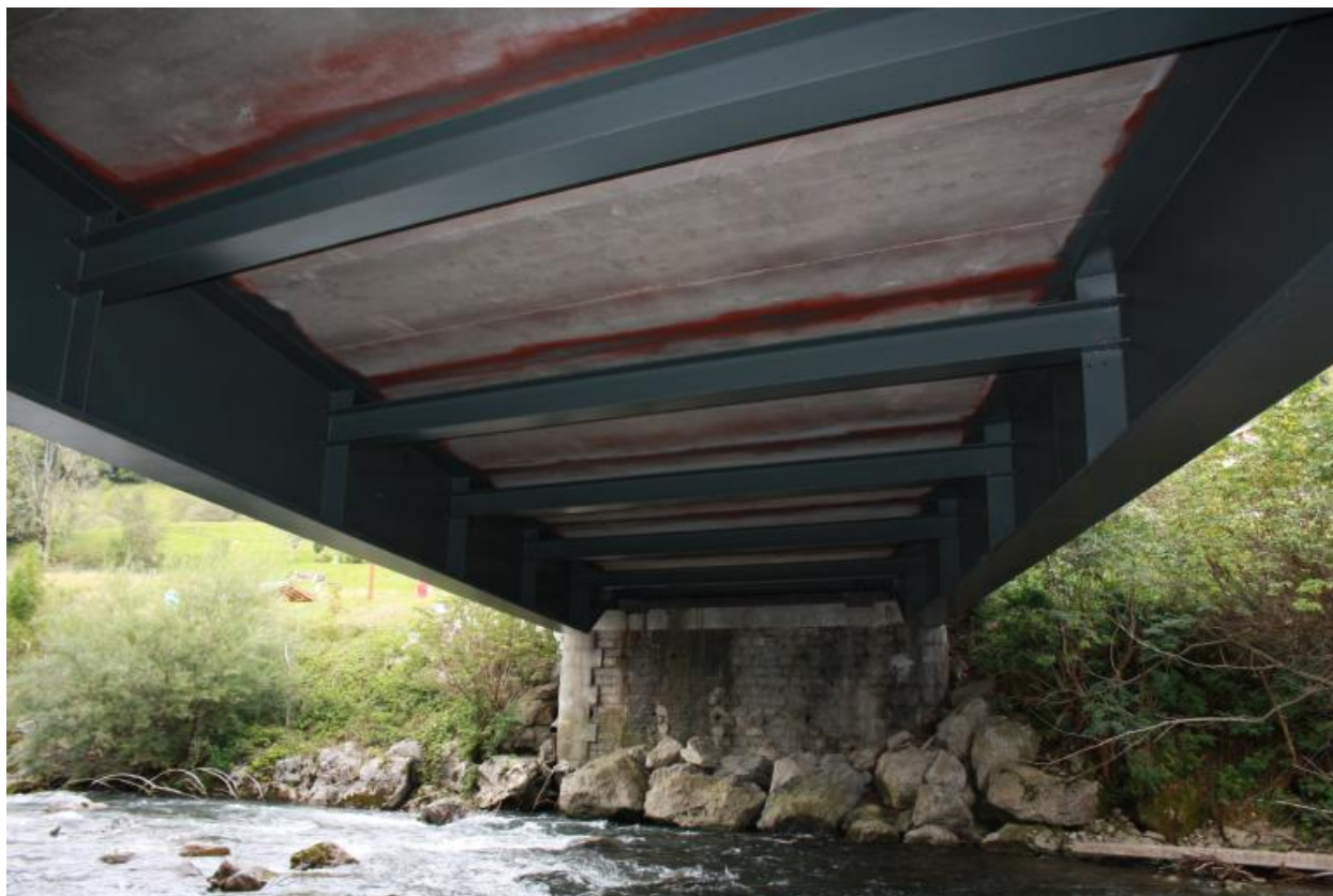
Pont des Plagnettes, détail structure porteuse
