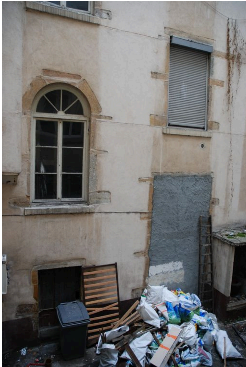
Elévation postérieure : porte murée donnant sur la cour commune
