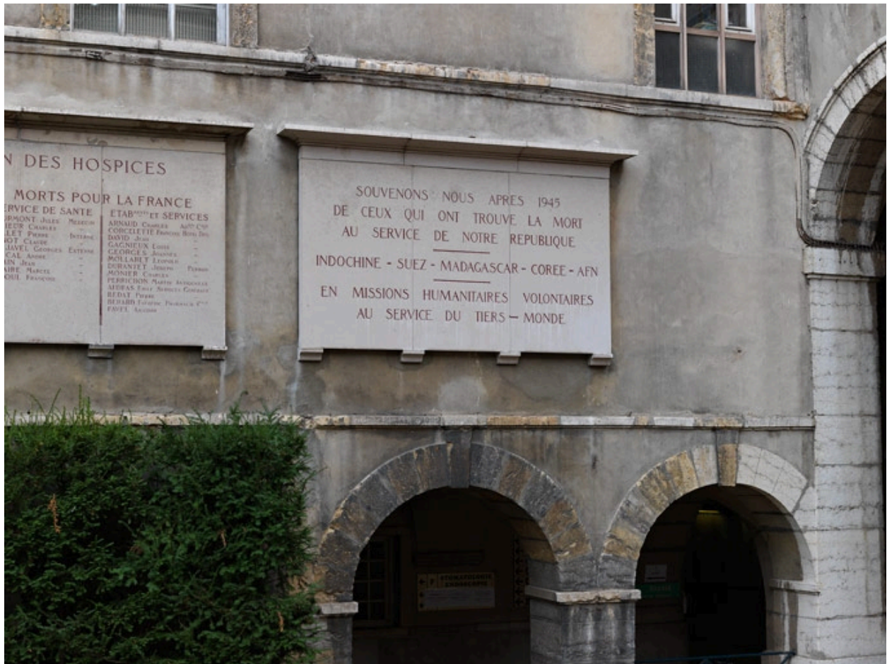
Plaque commémorative aux morts des guerres coloniales et des missions humanitaires apposée contre la façade sud du bâtiment L
