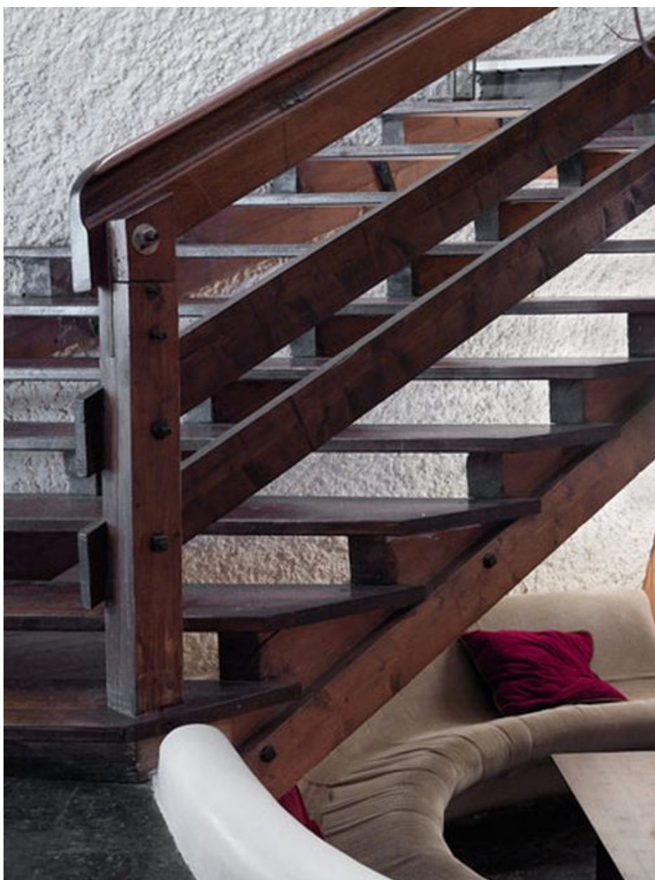
Garde-corps de l'escalier
