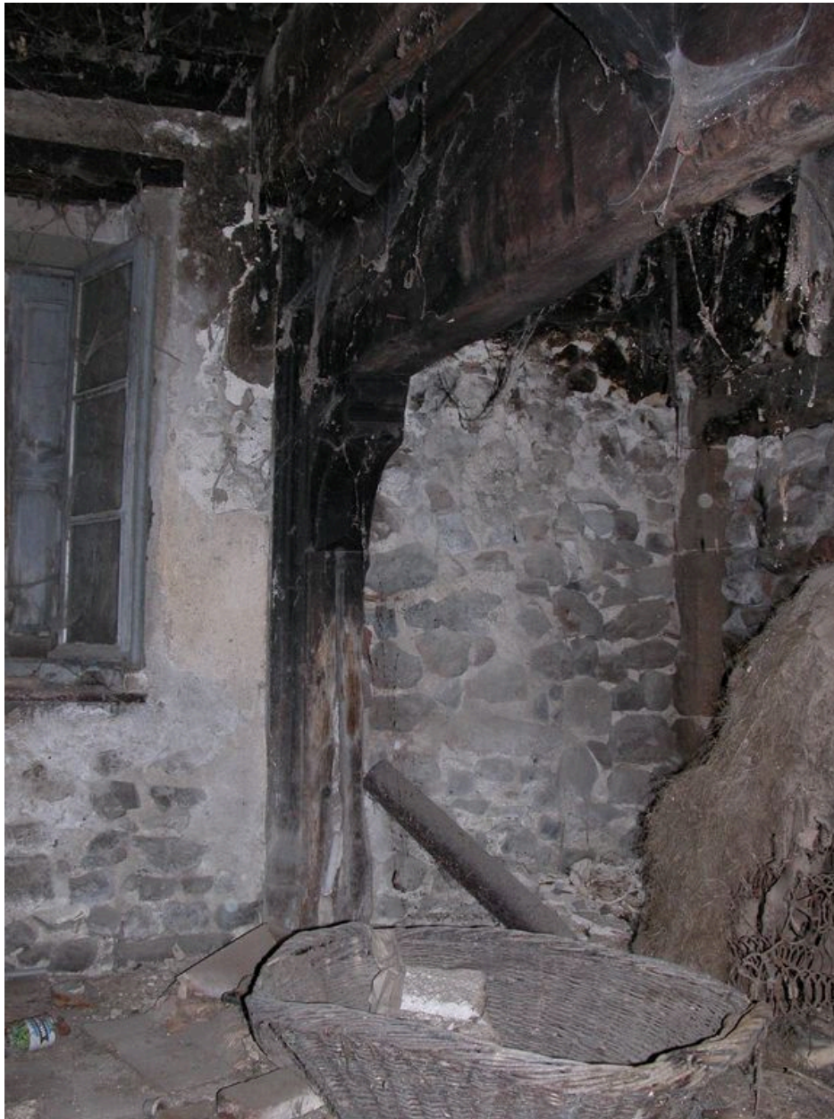
Vue intérieure de la cuisine : cheminée.
