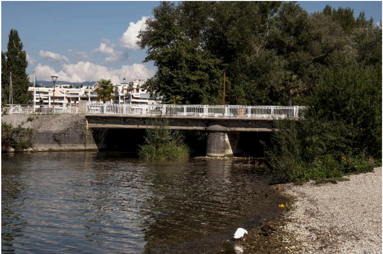
Pont sur le Sierroz : pile et tablier
