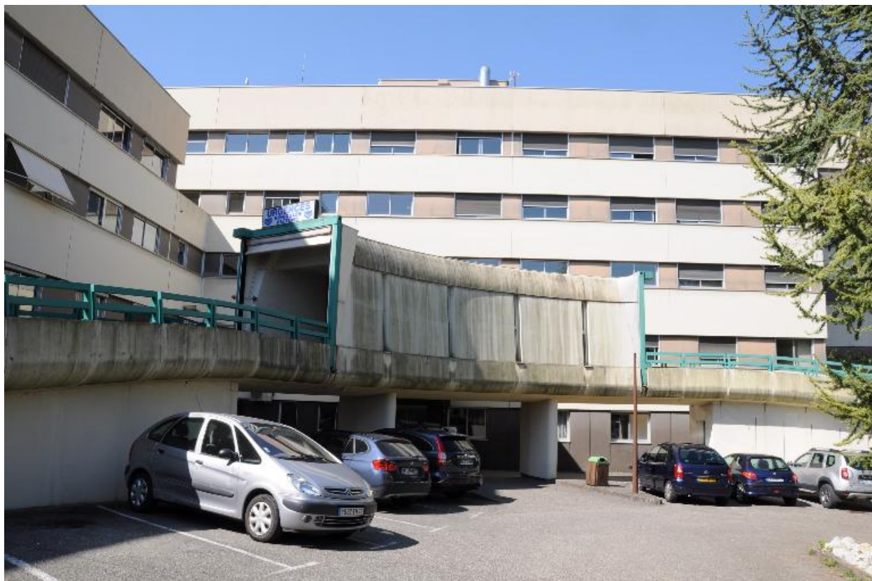
Rampe d'accès aux urgences, vue d'ensemble
