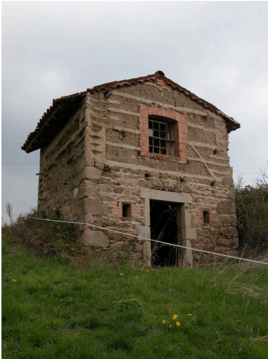
Vue d'ensemble du pigeonnier (?) ou loge de vigne.
