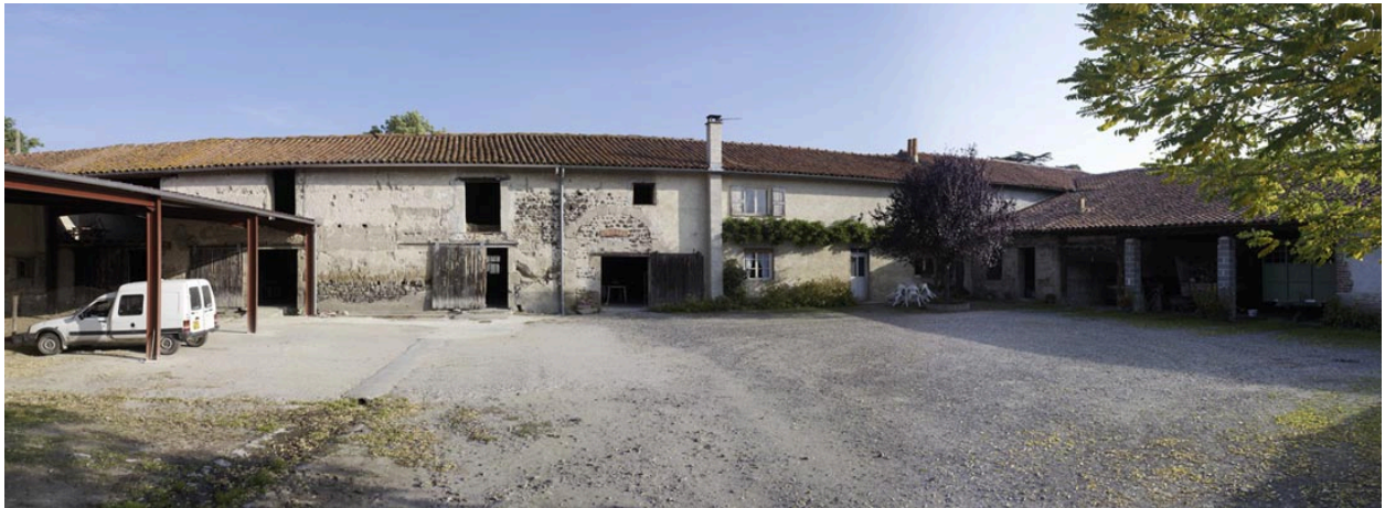
Corps de communs sud : vue générale depuis la cour de la ferme, du sud.
