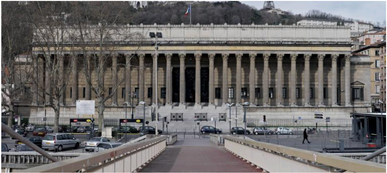
L'élévation antérieure depuis la passerelle du Palais de Justice
