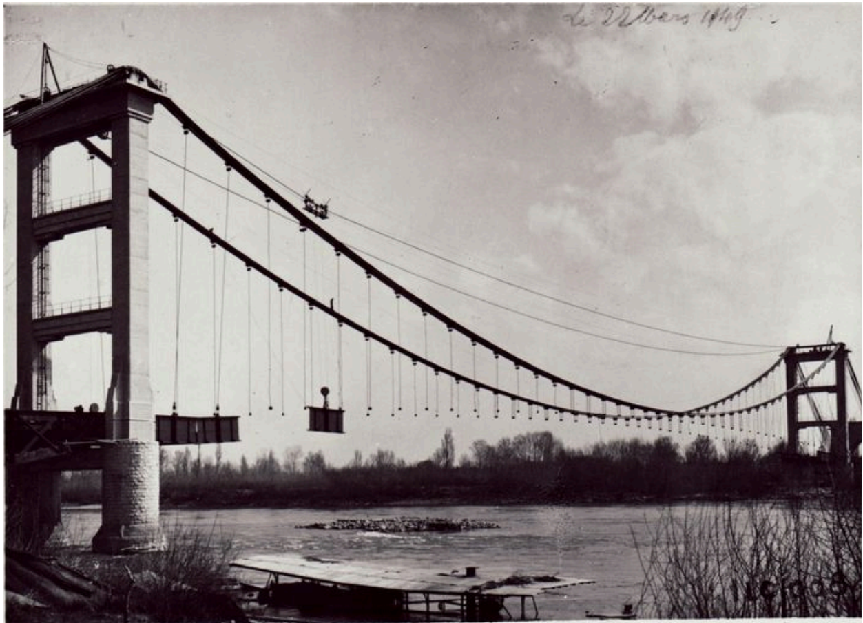
[Reconstruction du pont. Mise en place des poutrelles] / Fives-Lille (Givors) phot., [22 mars 1949]. 1 fotogr. pos. : n. et b. (Lyon, Inventaire général)
