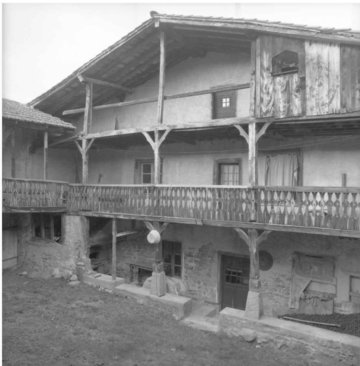
Vue d'ensemble de la façade à galerie sur la cour.
